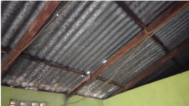
Fotografía 4. El techo interior construido con tejas de zinc y estructura de soporte en madera. Se evidencian múltiples perforaciones en las tejas, lo que permite el paso de la luz solar y, presumiblemente, también de agua en caso de lluvia. Estas filtraciones afectan las condiciones de habitabilidad, generando humedad y deterioro adicional en la estructura. La madera muestra signos visibles de desgaste y envejecimiento, lo que podría comprometer su resistencia.
