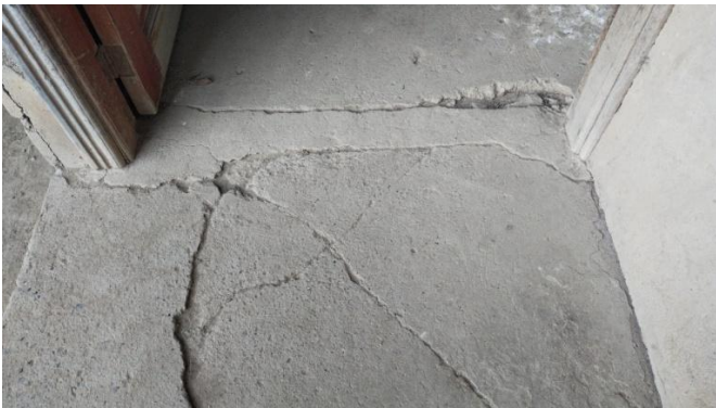
Fotografía 2. Se observa el piso interior de la vivienda, el cual presenta múltiples fisuras y fracturas de gran tamaño en la placa de concreto, así como desprendimientos en las juntas y desniveles marcados entre los diferentes tramos. Se evidencia deterioro estructural significativo, posiblemente ocasionado por asentamientos diferenciales o falta de cimentación.
