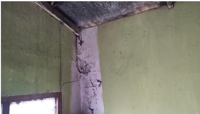
Fotografía 5. Se observa una fisura vertical de gran tamaño que compromete la unión entre dos muros, con desprendimiento parcial del revoque y agrietamiento profundo. Estas grietas podrían estar asociadas a movimientos estructurales o a asentamientos del terreno. Además, se nota deterioro del muro bajo la cubierta de zinc, lo cual podría agravarse con la presencia de humedad filtrada desde el techo.
