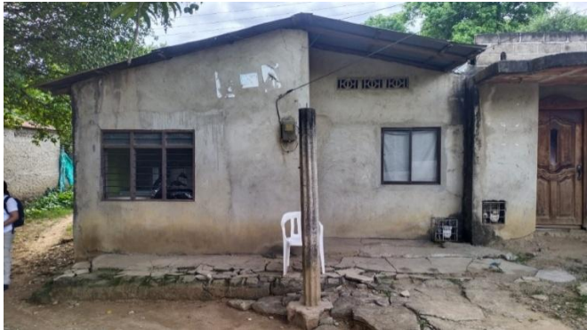
Fotografía 1. Fachada principal de la vivienda, donde se evidencian fisuras en los muros, desprendimiento del revoque, manchas de humedad, y un piso exterior en mal estado con losas fracturadas y desniveles.
