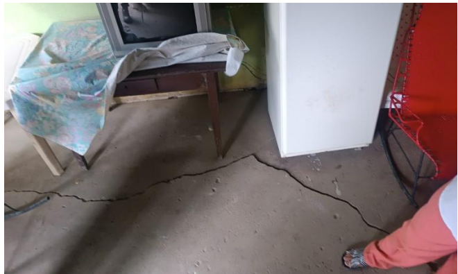
Fotografía 3. Se muestra una zona del interior de la vivienda donde se observa una grieta de gran longitud y profundidad en el piso de concreto, que atraviesa la habitación de lado a lado. Esta fisura evidencia un deterioro estructural progresivo del suelo comprometiendo la estabilidad del área.
